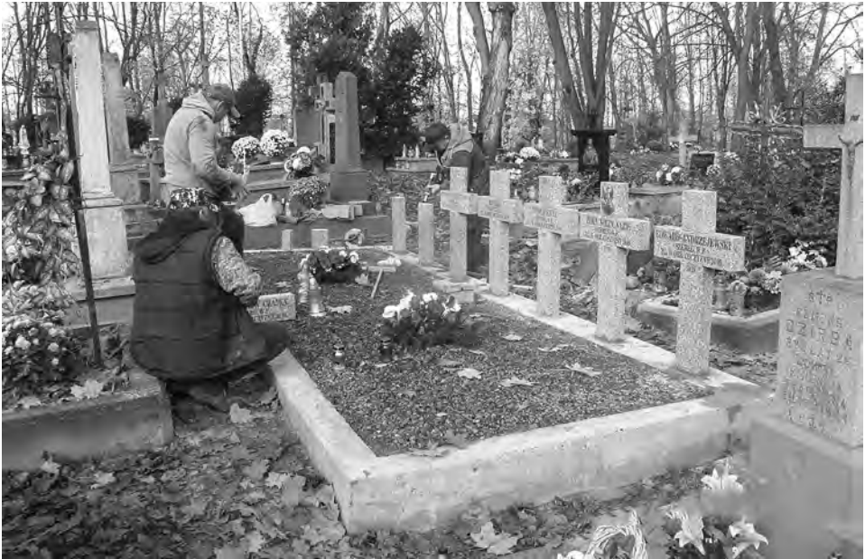
Fot. 56. Wymiana uszkodzonych betonowych krzyży na nowe z biało-szarego granitu strzegomskiego w listopadzie 2020 r., za środki pozyskane przez TPF z MKiDN
