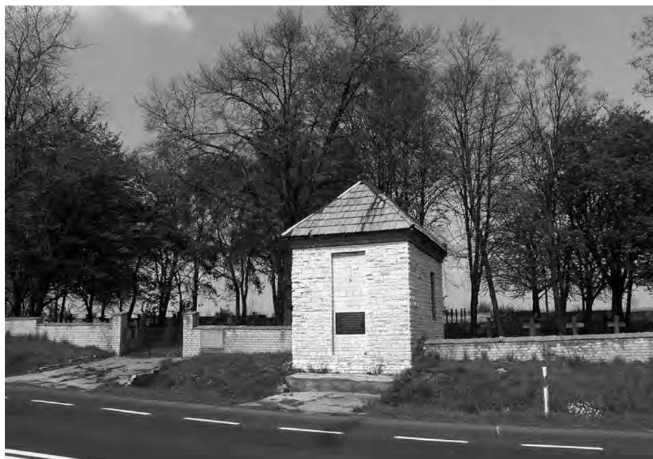
Fot. 12. Widok na cmentarz w Boniewie i kaplicę cmentarną od strony zachodniej. Choć omijać go będzie obwodnica Fajśławic przydatny tu byłby mały parking
